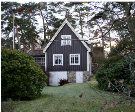
Hög grund av murad fältsten, med garage
