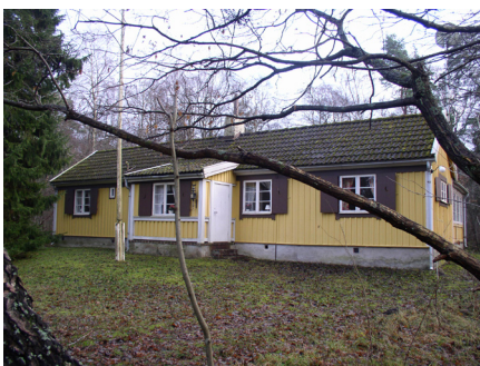
Vid ett första ögonkast syns inte att husen är tillbyggda. Det ursprungliga huset har dock tappat sina proportioner och symmetri när den byggs till genom förlängning av huskroppen.
