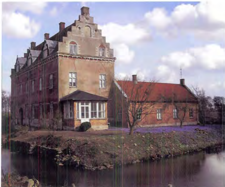
Den äldre borgen från 1590-talet med vårfior. Foto Stadsbyggnadskontoret 2006
